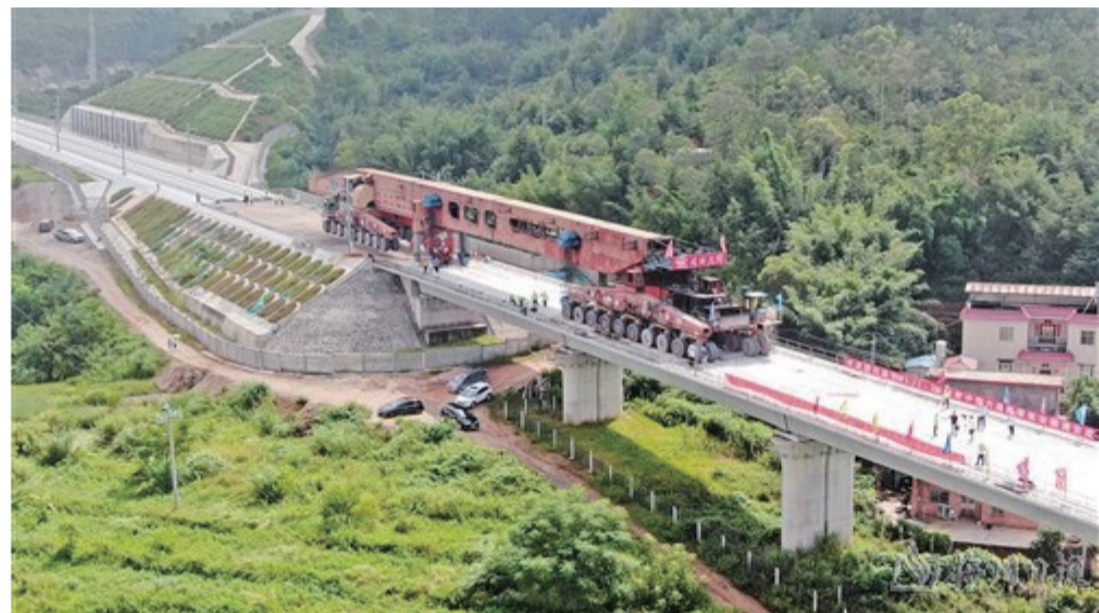
梅龍鐵路3標五華項目部501樁箱梁架設現場。(受訪者供圖)▶
